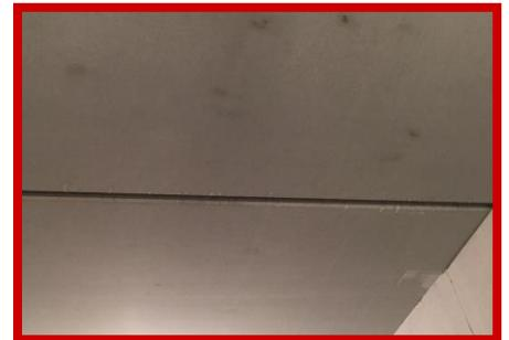
Une fois dépoussiéré le joint est propre et prêt à être jointoyé
